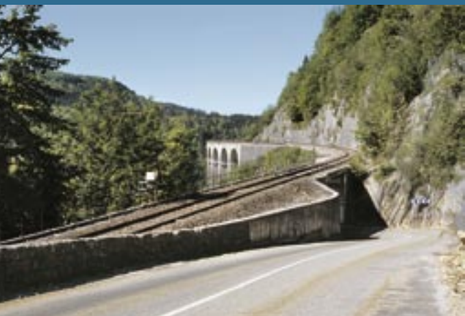
Morbier. Viaduc des Crottes (044.904) et pont sur la R.D. 18 (045.208). La pente passe de 25 mm/m sur le viaduc à 30 mm/m au-delà, le rayon de courbure de 180 m à 300 m.
