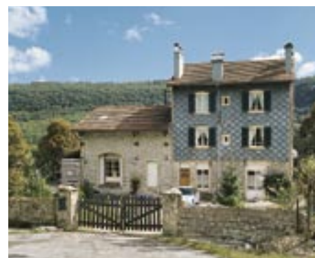
Gare de La Rixouse - Villard. Entrepôt à gauche, bâtiment des voyageurs à droite.
