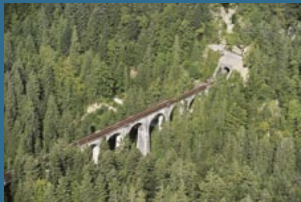
La Chaux-du-Dombief. Tunnel du Morillon (028.450) et viaduc du Dombief (028.934). Partiellement courbe, le tunnel est en rampe de 18 mm/m et le viaduc en palier (déclivité nulle).
