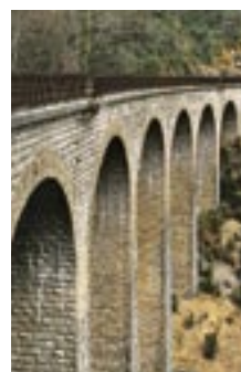
Saint-Claude. Viaduc de Valfin depuis le côté La Cluse : 6 arches de 10 m d'ouverture, dont la voûte en plein cintre est formée de 2 rouleaux.
