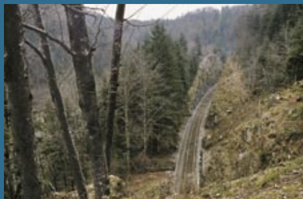
Le Vaudioux. Tranchée (024.400) à la sortie du tunnel de Malproche, côté La Cluse
