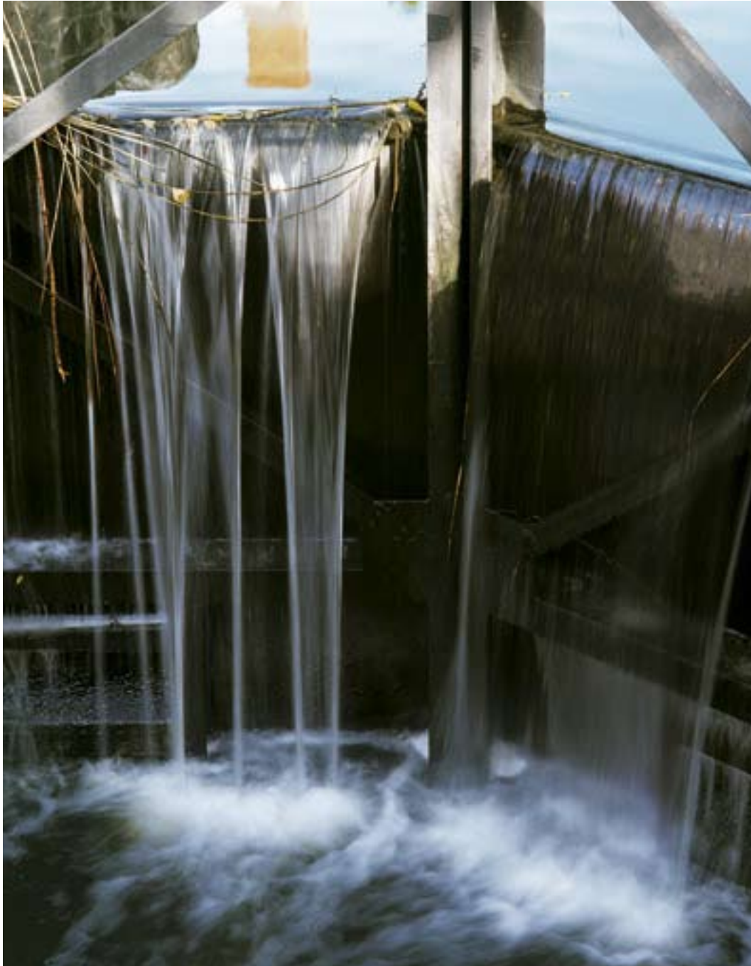
218 Détail d'une porte d'écluse du canal d'Orléans. Loiret MARIUSZ HERMANOWICZ
