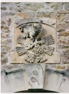
Fig 246 a – Distillerie coopérative de Nébian, 1909. Détail de façade avec emblème de la Confédération Générale des Vignerons (CGV).
