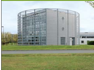
Occupé aujourd'hui par la SHEMA, cet édifice a été construit par les architectes caennais Gérard Dubois et Yves-Marie Douai pour une société informatique. Le carclage qui l'entoure évoque le système de sécurité d'un microprocesseur.
