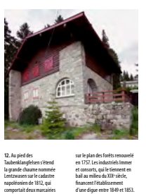
habille l'ensemble d'un gignon et d'une grande lucarne en pan de bois. Le gignon constitue l'élément le plus récent, comprenant une loggia en encorbellement couvrant par trois arcs trilobés ornés. Avant son bardage par des planches, la partie supérieure du gignon était faite d'une meule charpentée. La maison n'a été plus propriété communale depuis sa vente en 2004.
