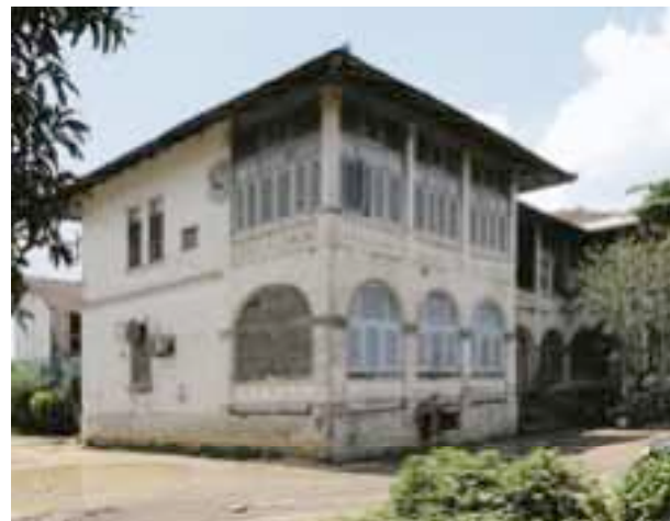
Ancienne maison des célibataires de la firme Woermann Linie, Bonanjo, vers 1927.
