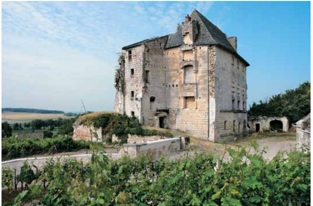
Vue au nord-ouest, avec la galerie au fond.
