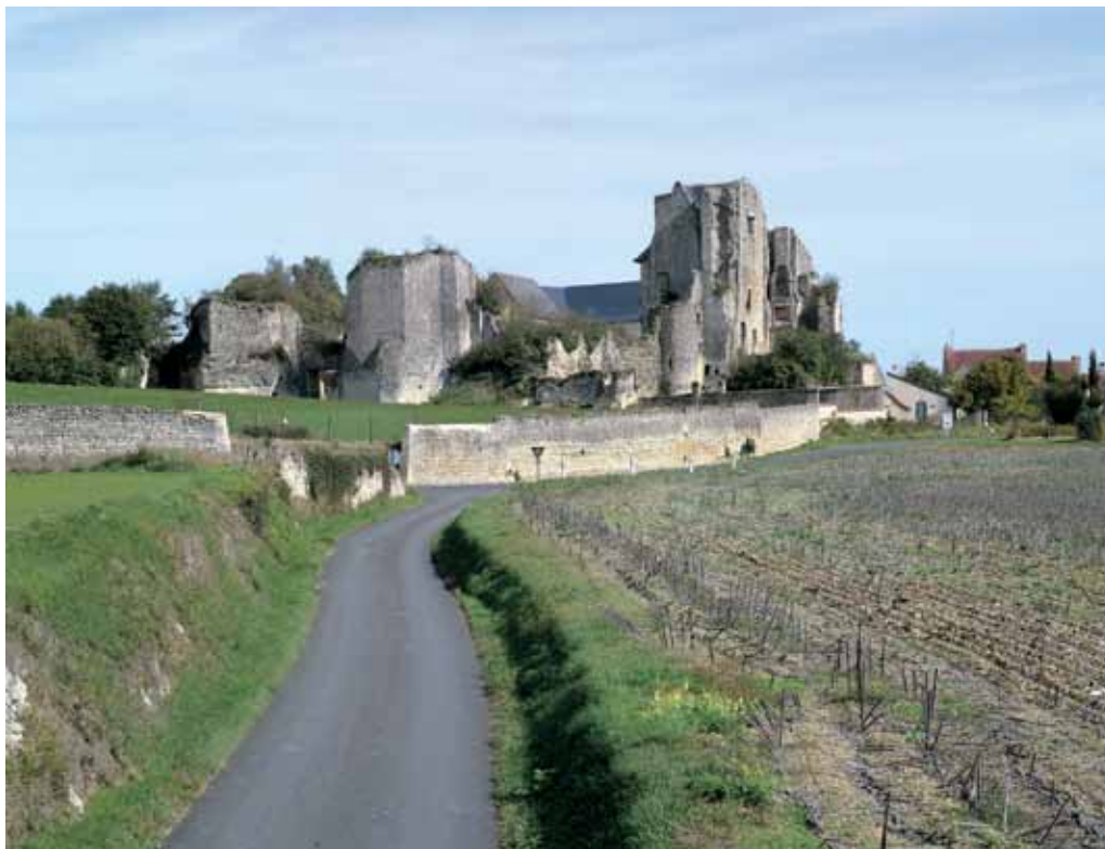
Le château vu du sud-ouest.
