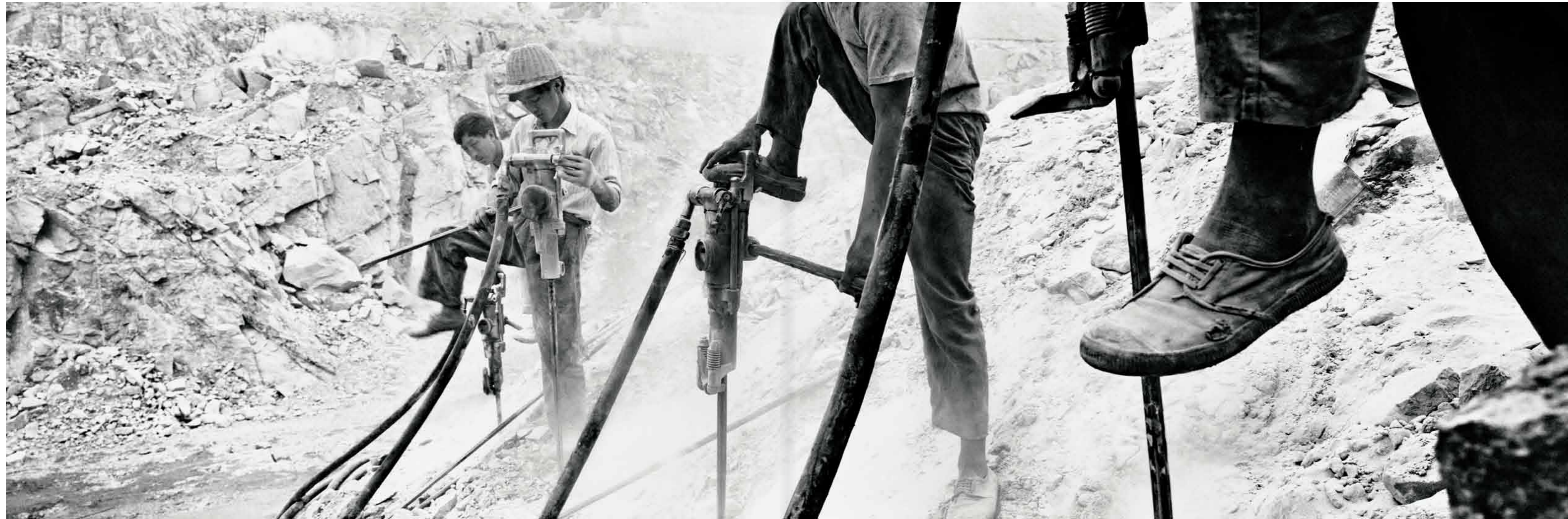
Le chantier du barrage des Trois Gorges, forages en vue du dynamitage de la roche, 1998.
