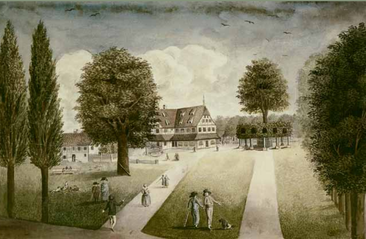
• (Fig. 26) : Le restaurant À l'Arbre Vert , qui est l'ancienne maison de la Société des arbalétriers et arquebusiers strasbourgeois a été construit en 1562. Dessin d'Abraham Débus, daté de 1796, DRAC Alsace, CRMH, DAR 482 B044_001.
