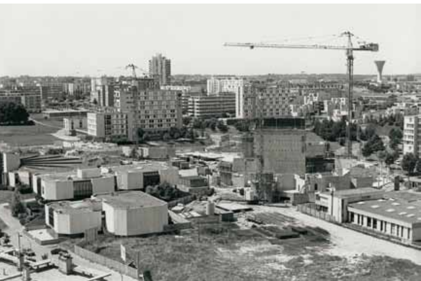
Chantier de la Citadelle Douce, 1985 (Arch. mun. Hérouville-Saint-Clair).
