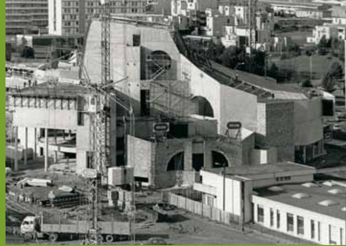
Construction des imposants volumes du théâtre, [ca 1986] (Arch. mun. Hérouville-Saint-Clair).
