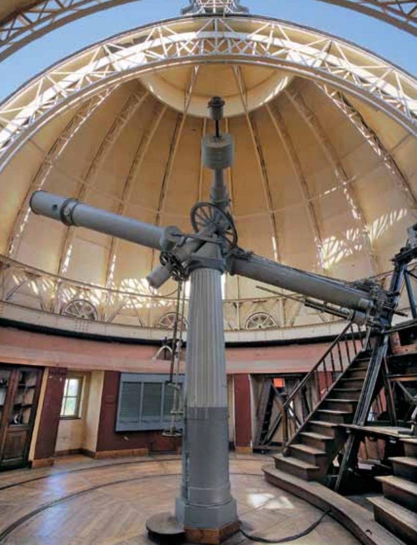
*La lunette de 49 cm sous la grande coupole en position ouverte. La fente d'observation, de 1,60 m de large, occupe un demi-cercle complet ; elle est obturée par deux trappes s'écartant l'une de l'autre selon un mécanisme identique à celui de la coupole de l'autre lunette équatoriale. Au sommet de la coupole, on distingue le système d'arrosage destiné à refroidir le métal et les pierres en cas de forte chaleur. Il semble qu'il n'ait jamais fonctionné.*
