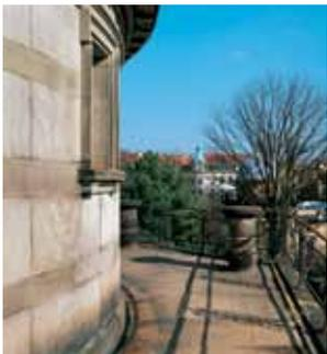
*À l'extérieur, une terrasse avec garde-corps en fer forgé, est située légèrement en contrebas du plancher de la salle d'observation au sommet de la tour carrée. Elle est équipée de piliers pour instruments mobiles à ses quatre coins et d'un rail circulaire destiné au chercheur de comètes Repsold que Winnecke avait mis en service dans l'ancien observatoire de l'Académie.*
