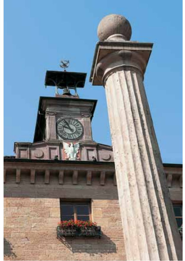
Mairie. Vue rapprochée du campanile à horloge. Cet édicule, construit en pierre de taille de la carrière de Granges-la-Ville (Haute-Saône) porte les armes du bourg.
