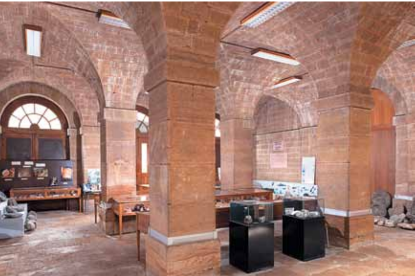
Mairie. Halle située au rez-de-chaussée.
