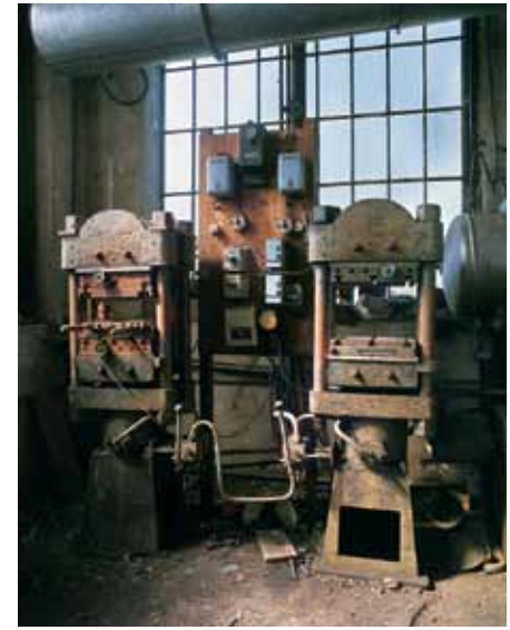
Chabreloche, usine Emile Cotte : le tableau électrique.
