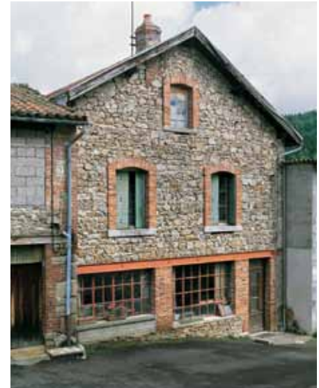
La Monnerie-le-Montel, bourg : le linteau de la « vanne » est un IPN courant sur toute la façade.
