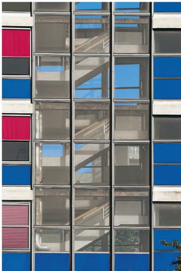
Des baies vitrées sur toute la hauteur des cages d'escalier permettent à la fois d'éclairer l'intérieur de l'édifice et de laisser passer le regard.
