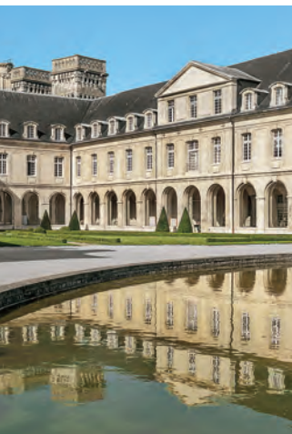
Façade méridionale de l'aile nord du cloître se reflétant dans le bassin en hémicycle.
