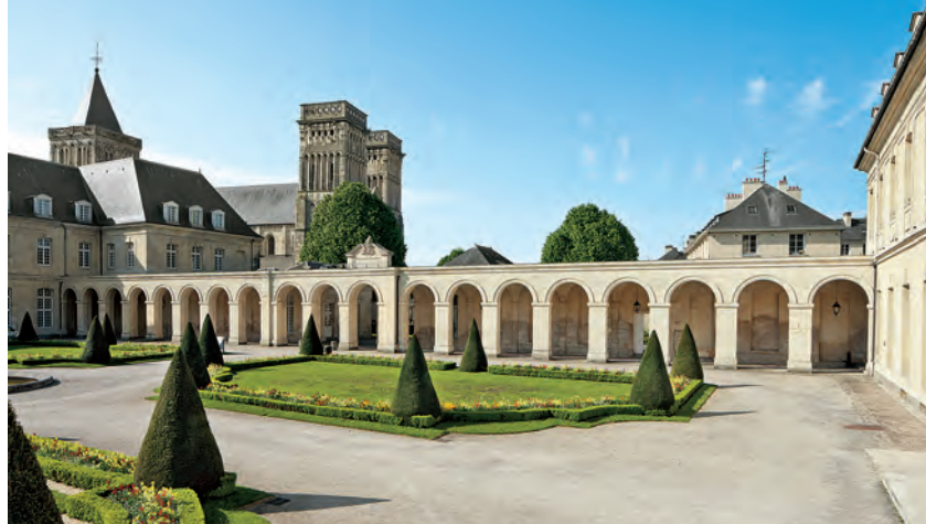
Vue de la cour d'honneur depuis l'angle nord-est.
