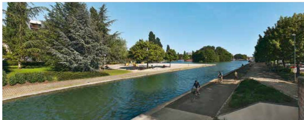
Le port du canal à Dijon vu vers l'aval, bief 55 du versant Saône.
