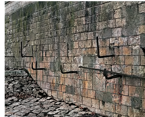
En aval du port, des organeaux et des ancrs sont fixés pour l'amarrage des bateaux dans le mur vertical de protection des ouvrages du canal contre les crues de la Loire.
