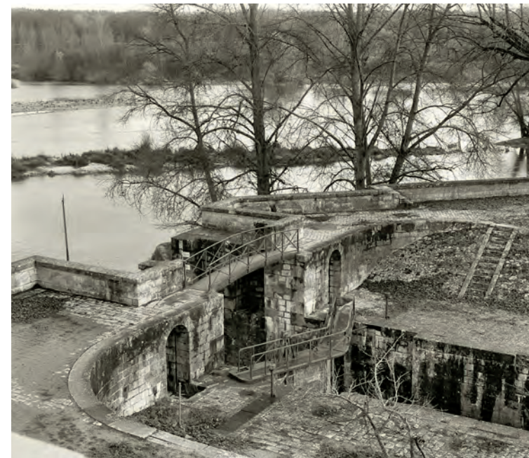
L'écluse de descente en Loire de Mantelot.
