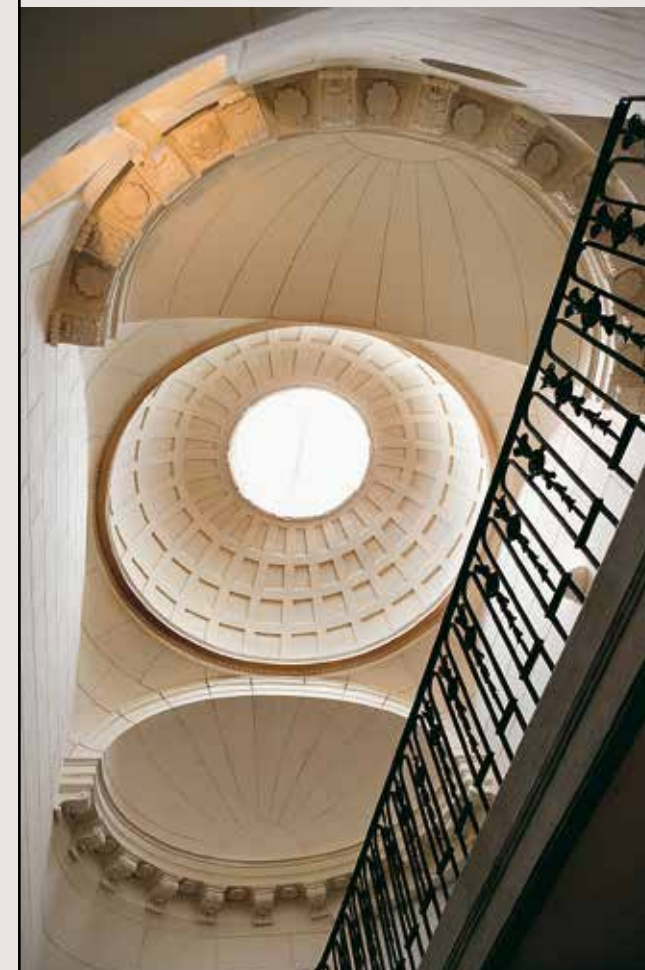
↓ Hôtel de Buyer : vue de la coupole et des demi-coupoles couvrant la cage d'escalier.
