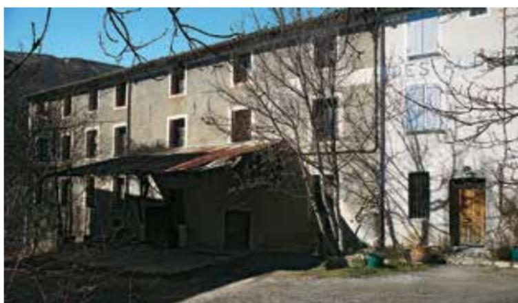
*La minoterie Dol vue au début du 20<sup>e</sup> siècle et en 2014. On distingue bien la différence de largeur des travées entre l'extrémité du bâtiment et la partie centrale où se trouvent les mécanismes.*
