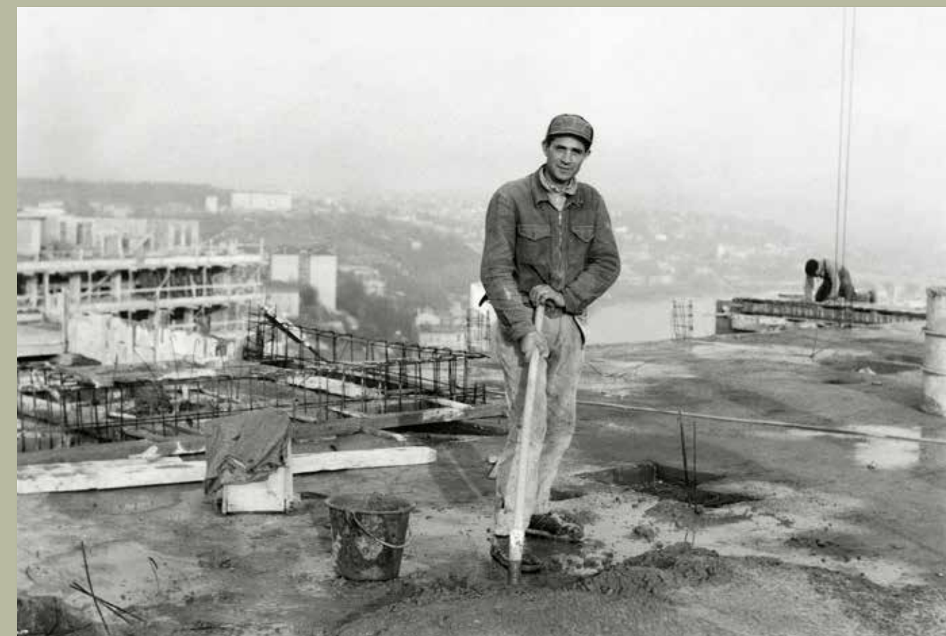
Nicola Franchella, originaire des Abruzzes, sur un chantier à la Croix-Rousse.
