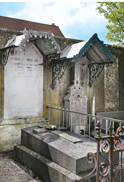
Cimetière de Vaucelles, exemples de couvertures en zinc à décor de lambrequins.
