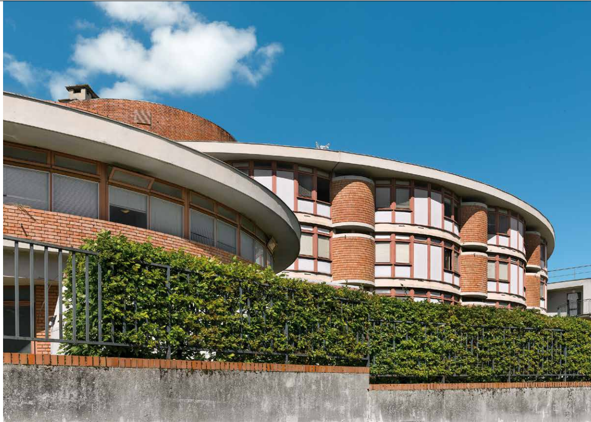
Vue actuelle d'une partie de la façade postérieure de la clinique.
