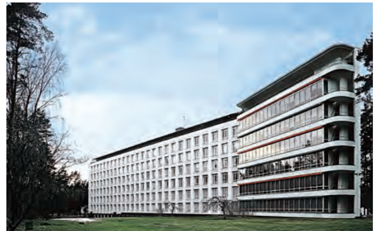
395. Paimio (Finlande), sanatorium. Au premier plan, les galeries de cure autrefois à l'air libre ont été vitrées.
