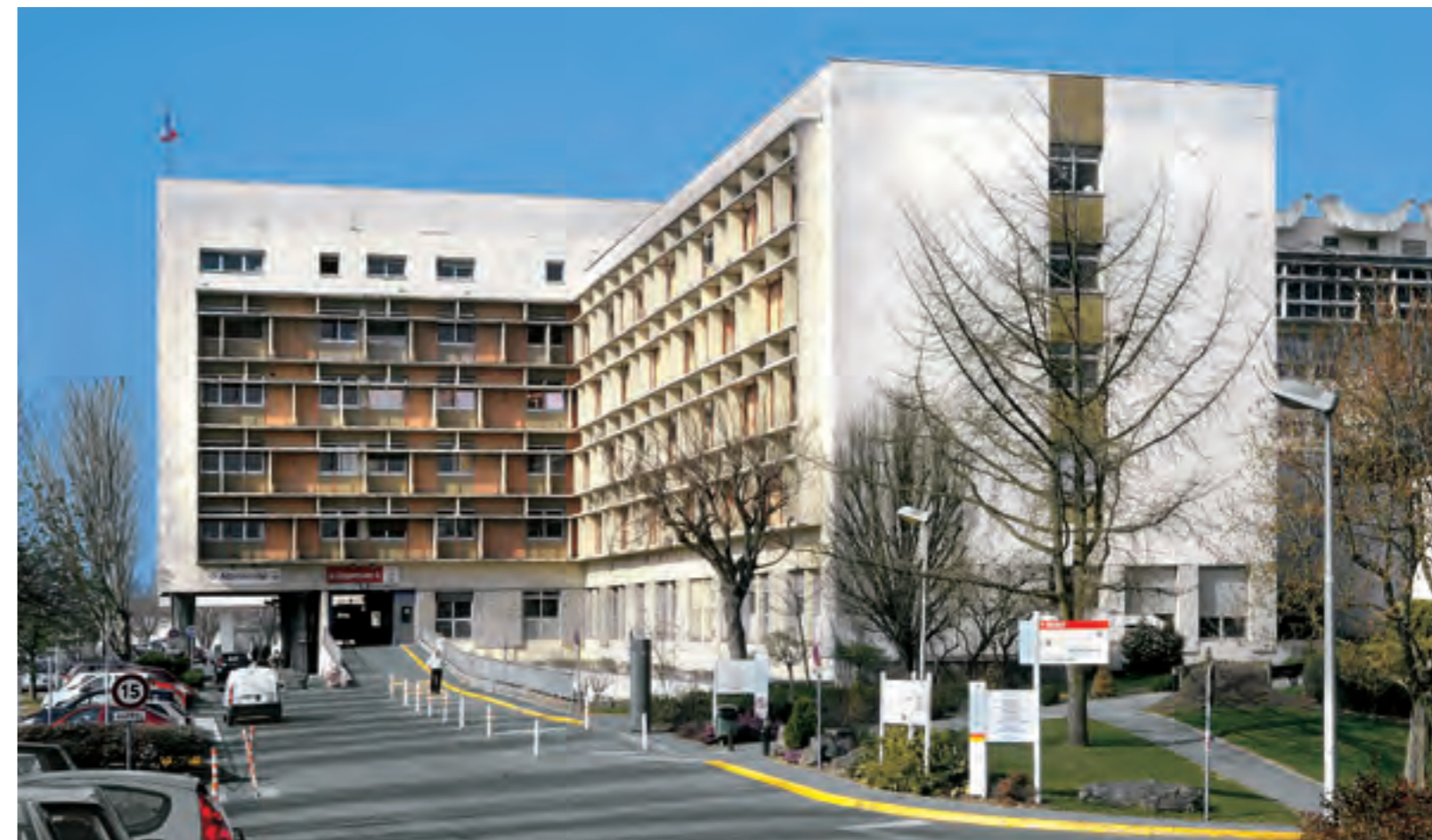
495. Bondy (Seine-Saint-Denis), hôpital Jean-Verdier.
