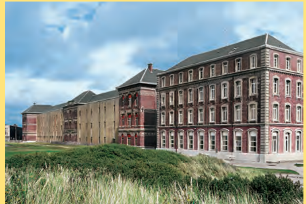
Berck, hôpital Napoléon (grand hôpital maritime). Au premier plan, pavillon latéral gauche du premier édifice ; à l'arrière-plan, bâtiment ajouté au nord en 1905-1910.
