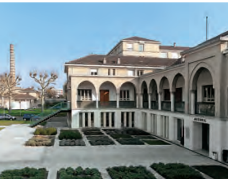
391. Bobigny (Seine-Saint-Denis), hôpital franco-musulman Avicenne. L'escalier extérieur conduisant à l'entrée a été supprimé et l'accès à l'établissement déplacé au niveau du soubassement.
