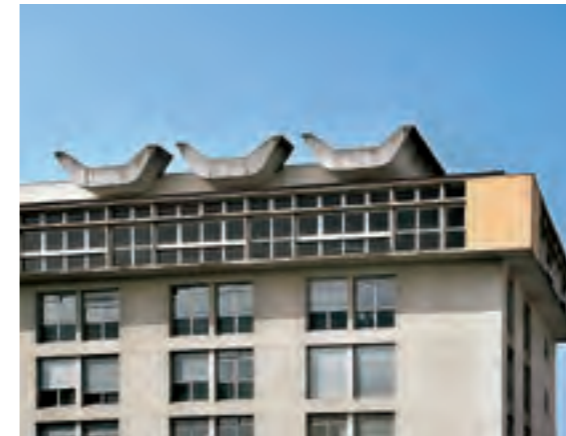
494. Bondy (Seine-Saint-Denis), hôpital Jean-Verdier. Détail de la toiture d'une des ailes du bâtiment.
