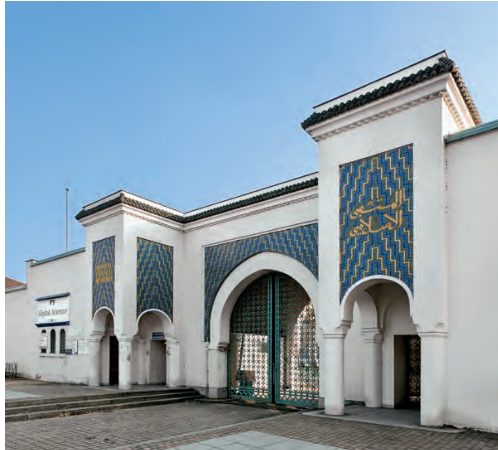
392. Bobigny (Seine-Saint-Denis), hôpital franco-musulman Avicenne. Porte d'entrée au site.
