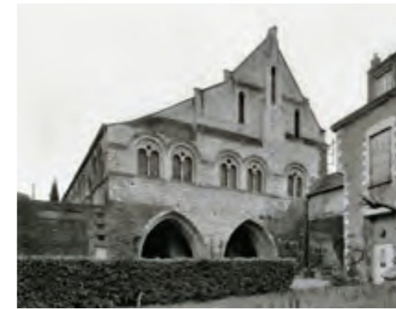
11. Angers, hôpital Saint-Jean. Bâtiment dit des greniers destiné au stockage des denrées.
