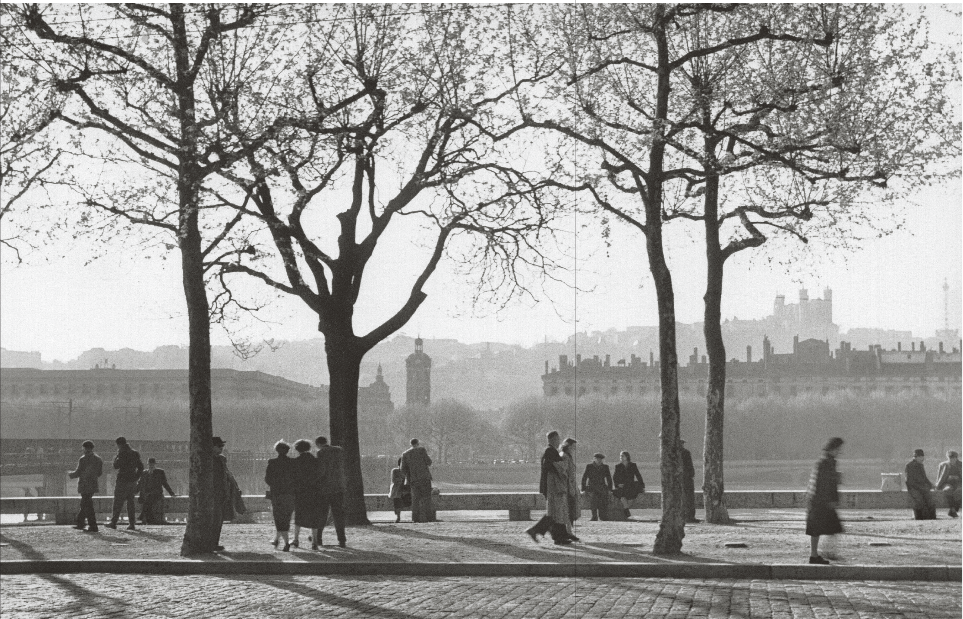
Quai Claude-Bernard, vers 1952. © Blanc-Demilly À gauche, le pont provisoire construit entre la place Raspail et la place Antonin Poncet pendant les travaux de construction du nouveau pont de la Guillotière, mis en service en 1958. L'ancien pont, endommagé en 1944, est détruit en 1952.
