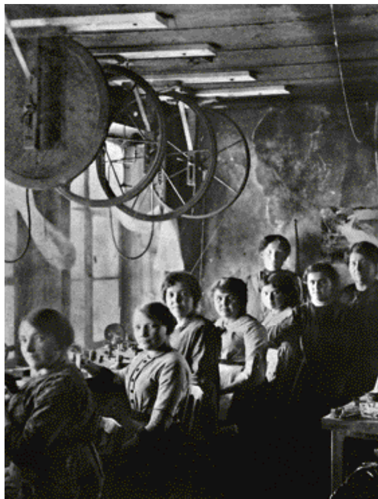
Atelier de la maison Vuillemin en 1917, à Bonnétagé.
