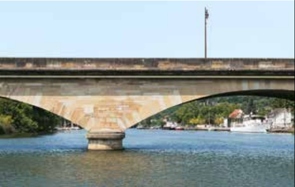
Pile et arche du pont Neuf de Limay.
