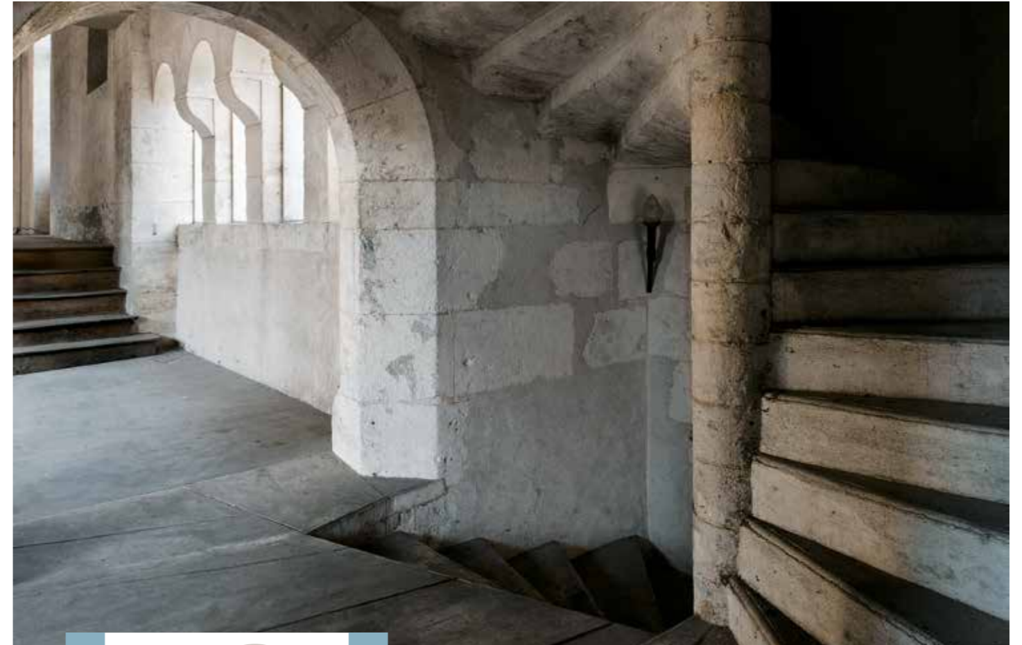
Escalier et galerie, hôtel du Soleil d'Or, Nogent-le-Rotrou (Eure-et-Loir).
