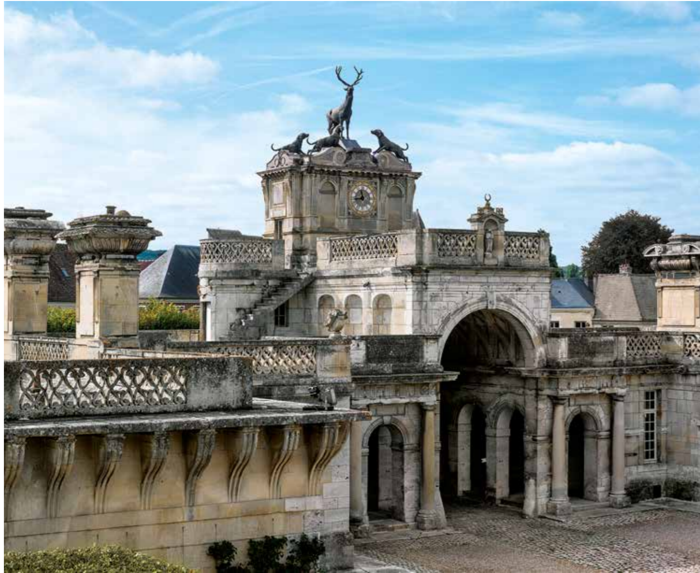
Ouvrage d'entrée, château d'Anet (Eure-et-Loir).
