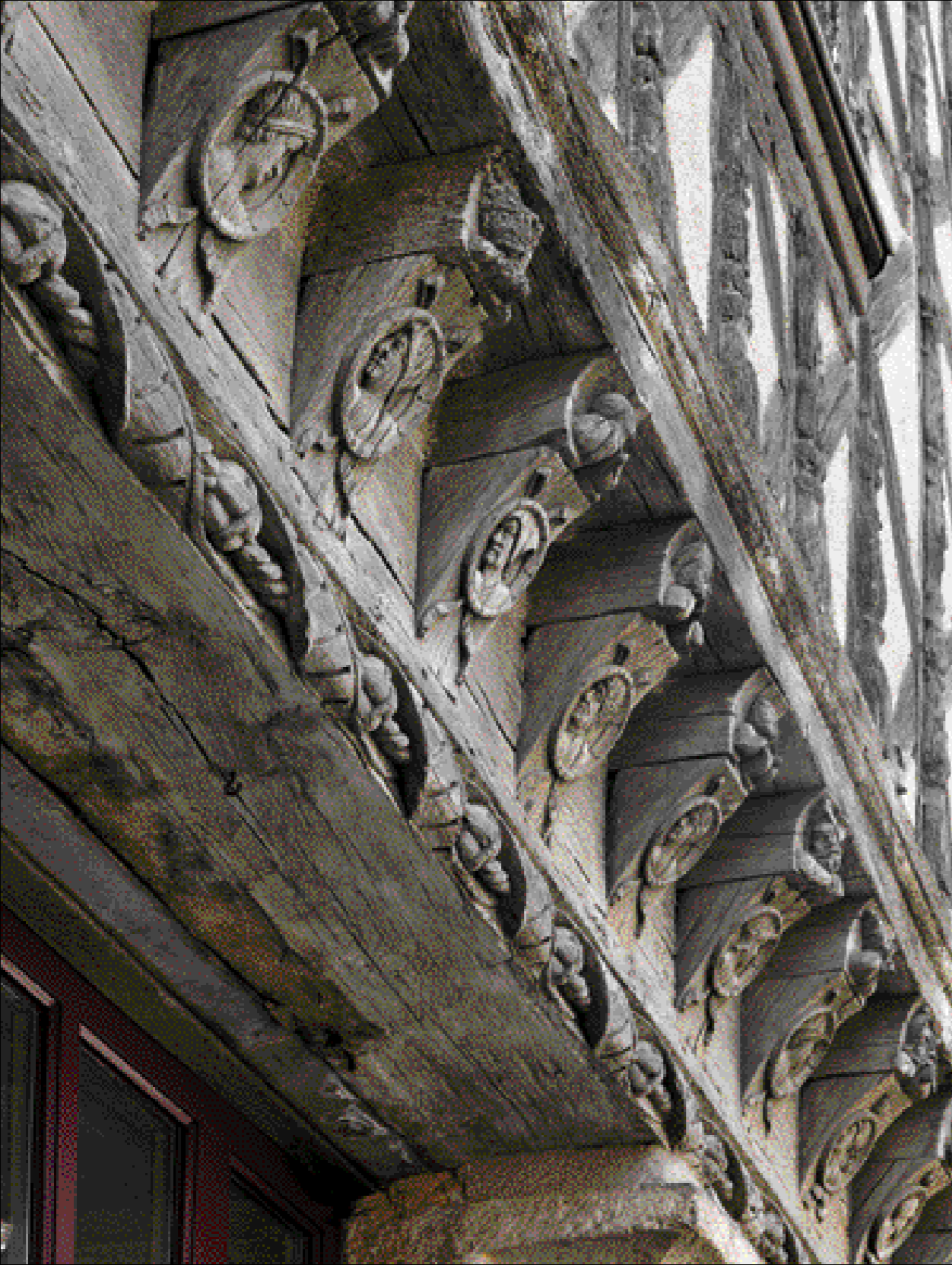
[ Détail du décor de la sablière, maison dite Louis-Esnault, rue Saint-Lubin, Châteaudun (Eure-et-Loir). ]
