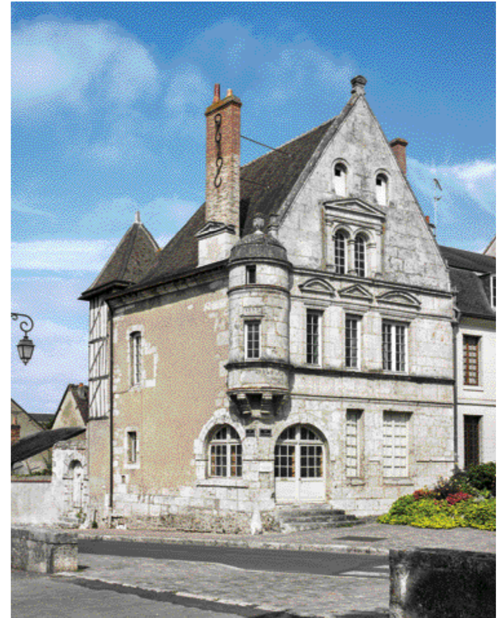
Maison située à l'angle des rues de la Cuirasserie et des Huilleries, Châteaudun (Eure-et-Loir).
