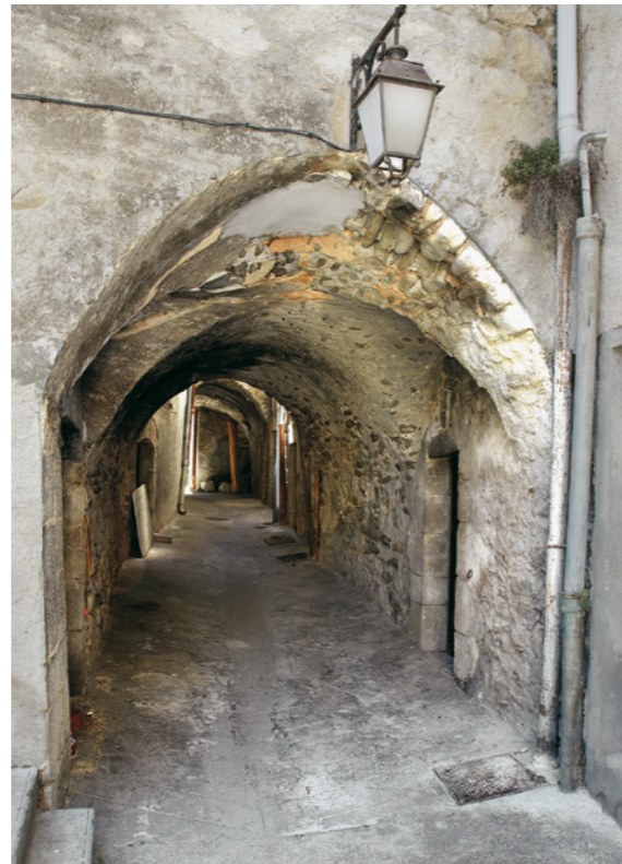
La voûte, ruelle d'Entrevaux.
