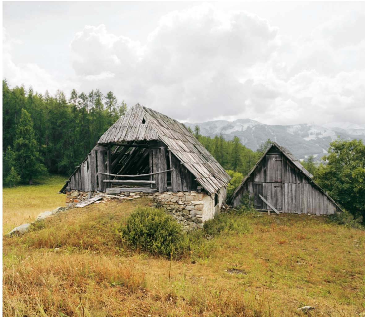
Ferme des Bois à Vacheresse, montée de grange et pignons en planches.
