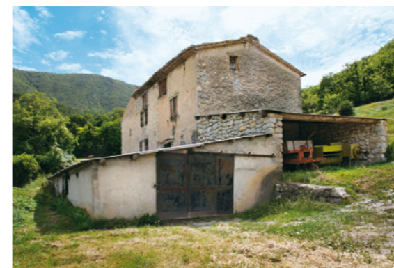
L'une des trois fermes de Pierre François Bernard, au lieu-dit la Basse Rente (actuellement Valbonnette, Entrevaux).
