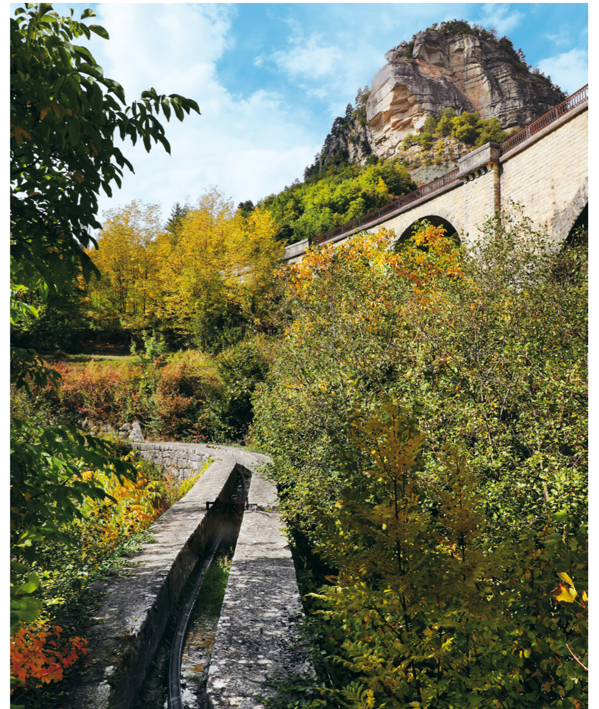
Canal d'irrigation de la Tourtourière, surplombé par le pont aqueduc enjambant la Beïte (Annot).
