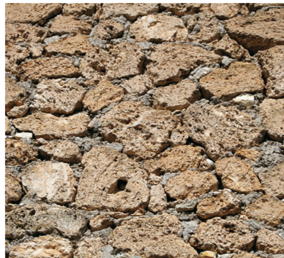
Maçonnerie de moellons de tuf à l'Isle (Vergons).
