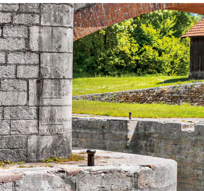
Repères de crues sur la culée du pont de l'écluse du Châtelet (21).
