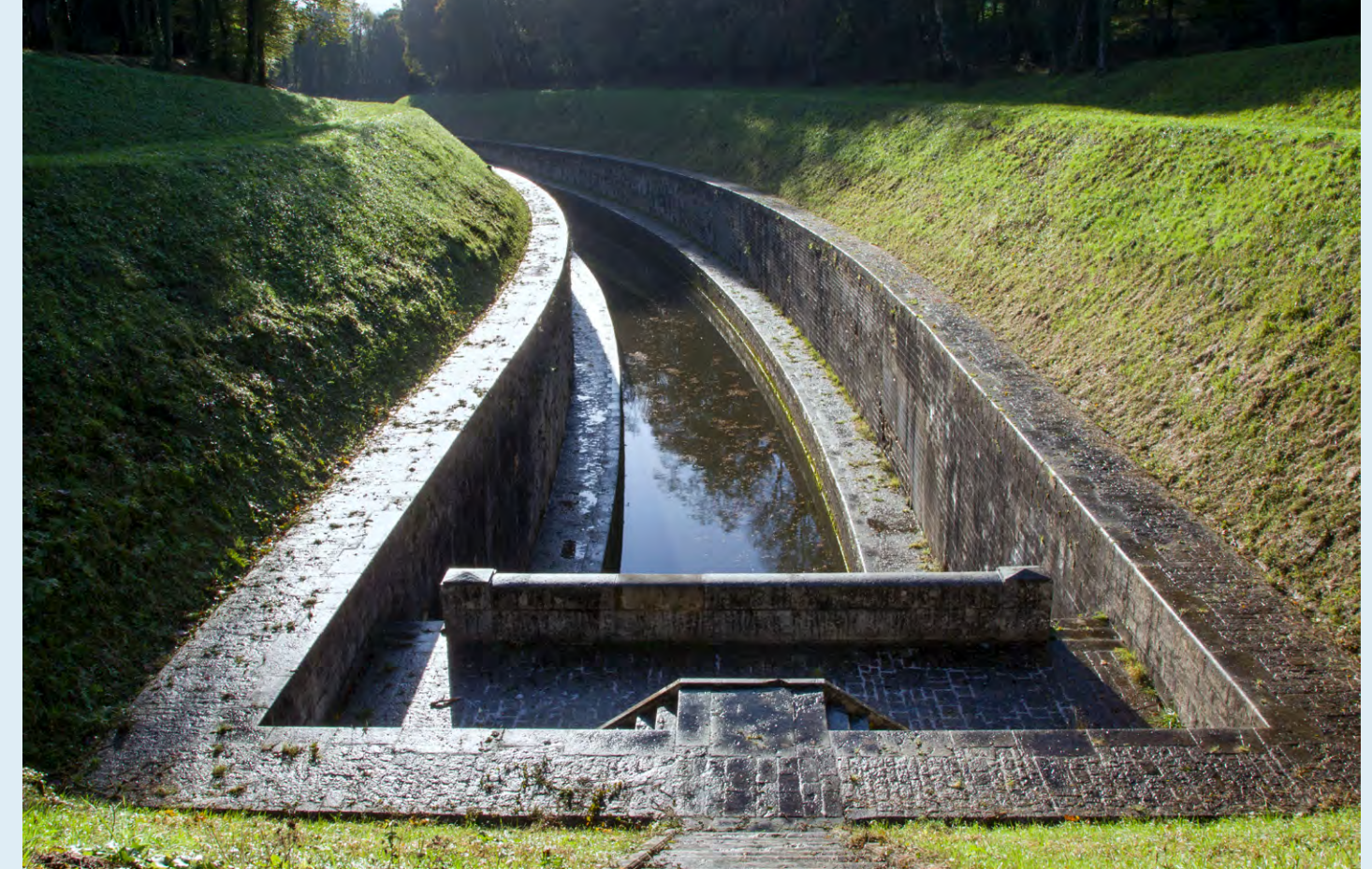
Entrée aval du tunnel.
