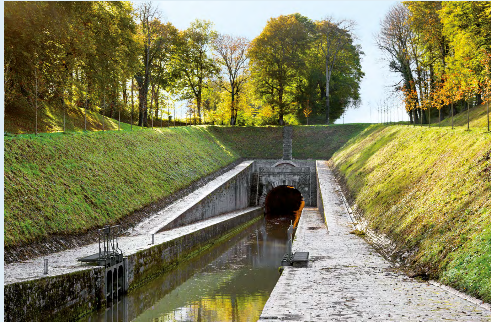
Partie amont du tunnel : canal de navigation et entrée.
