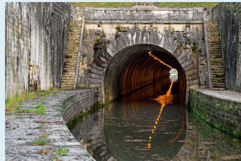
Le souterrain et sa voûte.
