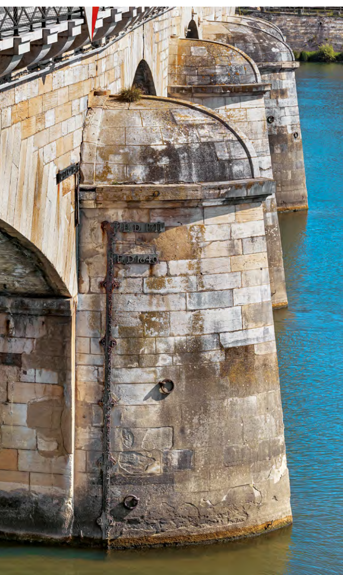
Repères de crues sur la culée du pont de l'écluse du Châtelet (21).
