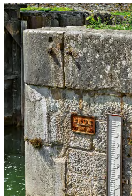
Repère de crue sur la porte de garde de Rigny (70).
