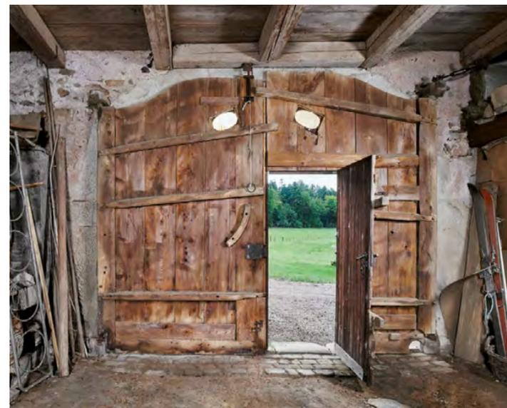
pièce de bois traverse le mur et est bloquée sur la façade par une clavette. Le verrouillage des vantaux se fait de manières variées. La plus courante est le blocage sur un vantail d'une traverse fixée sur le second.
