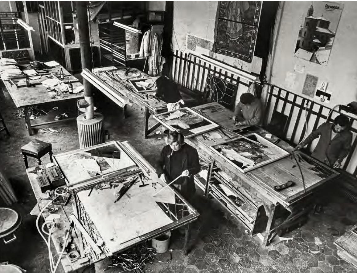
Intérieur du grand atelier en 1883. Dès 1876, le grand atelier était équipé de tuyaux d'amenée de gaz pour l'éclairage et pour l'alimentation des fers à souder. Sur cette photographie de la fin du xx e siècle, on observe que les ouvriers utilisent encore des fers à souder à gaz. Photographie conservée à l'atelier Lorin.
