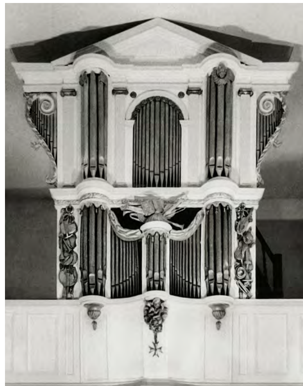
Georges Matrat, photographie montrant l'état ancien du buffet, milieu du XX e siècle. Médiathèque du patrimoine et de la photographie.
