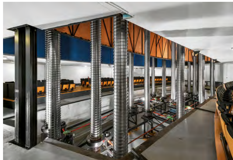
Supports du plancher de la fosse d'orchestre au niveau - 5,60 m.
