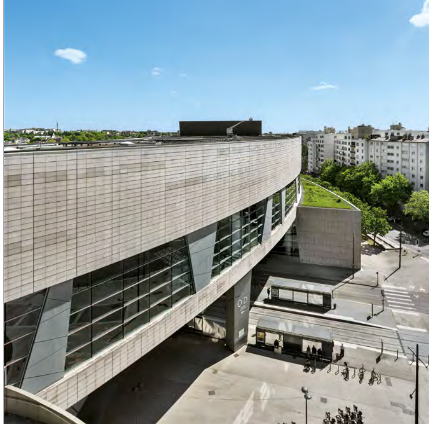
Vue plongeante sur la façade de l'auditorium.
